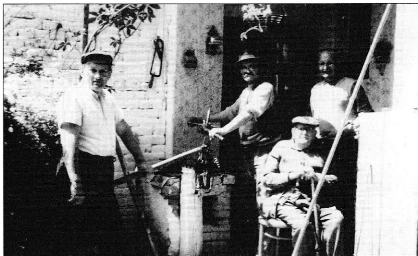
Vízvezeték szerelése Fehér Mihály bácsinál a szomszédok segítségével
